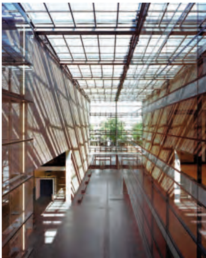
Abb. 3 Blick in das Foyer, rechts der Verwaltungstrakt
